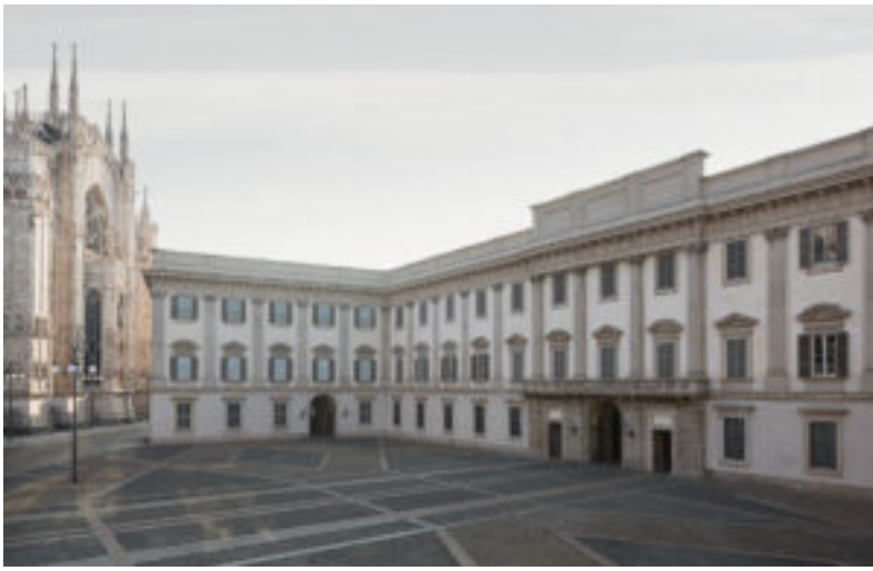
Veduta di Palazzo Reale a Milano
