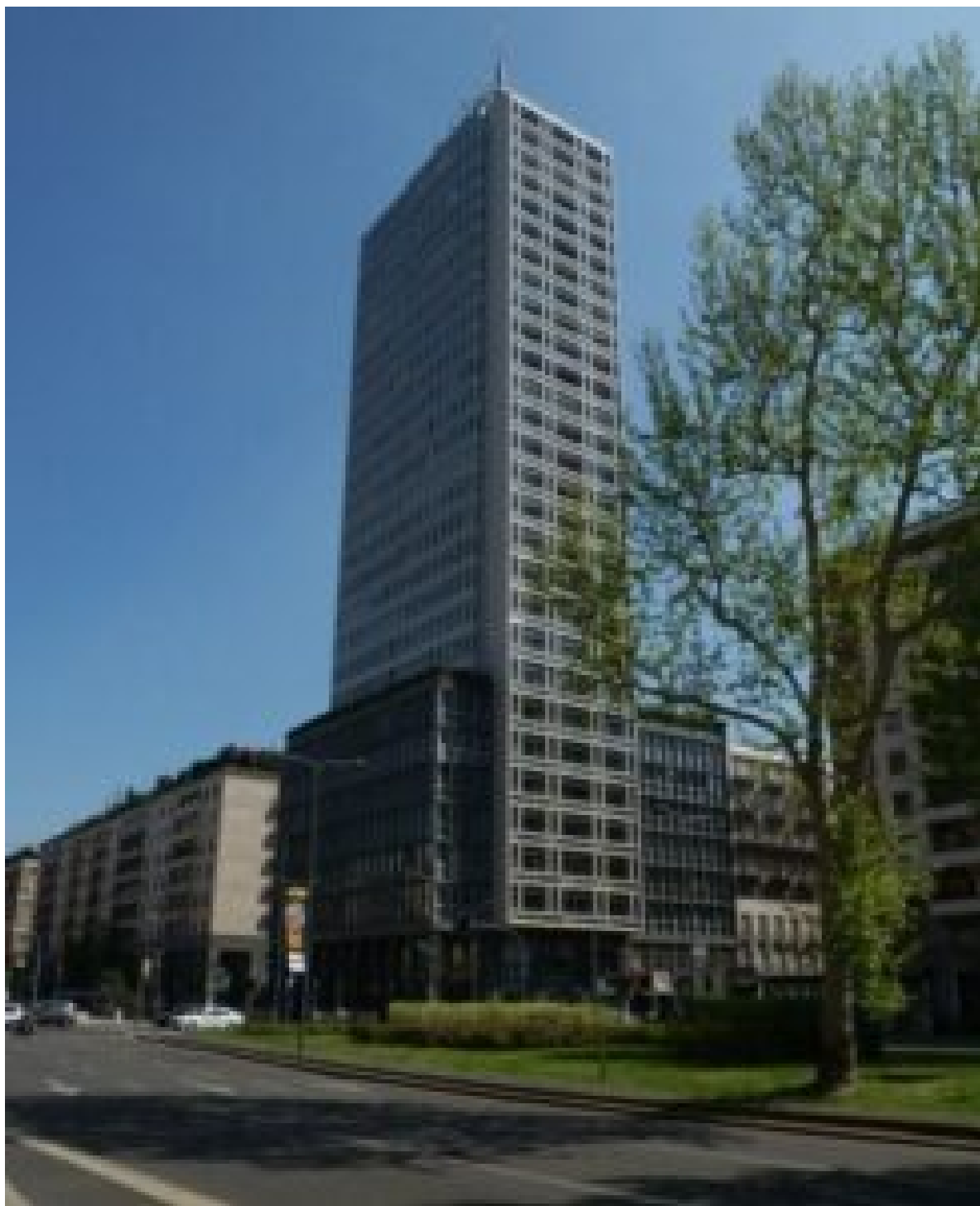
“Torre Breda vista da via Vittor Pisani”
