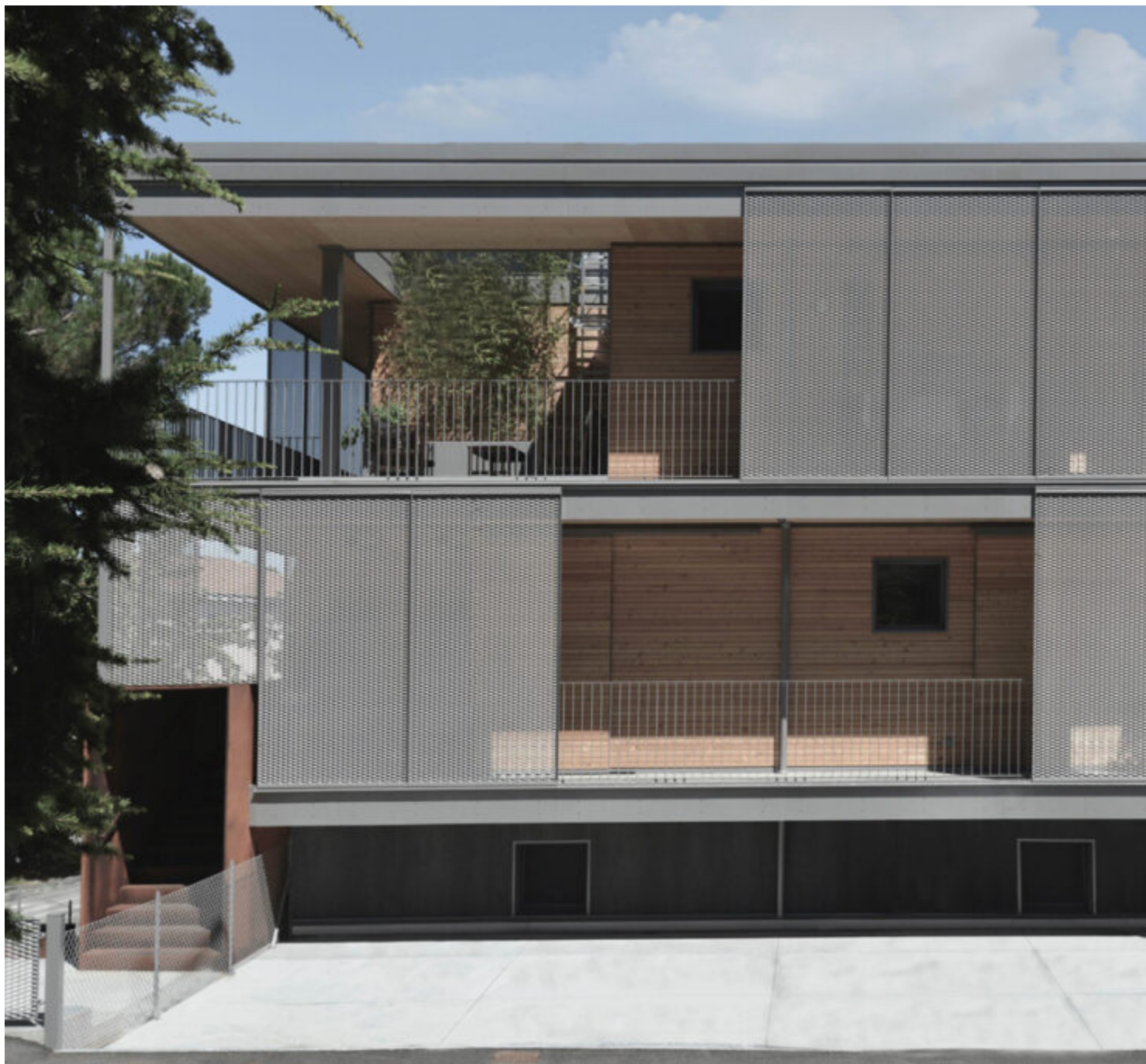
Fiorita passive house, Cesena, Stefano Piraccini e Margherita Potente, 2016. Edificio residenziale realizzato con standard Passive House.
