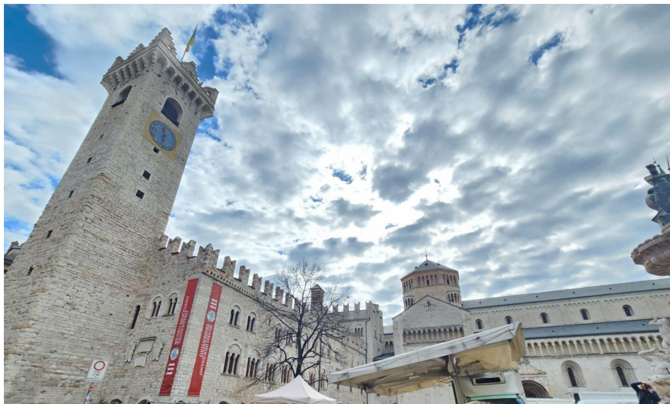
Edifici affacciati sulla Piazza Centrale
