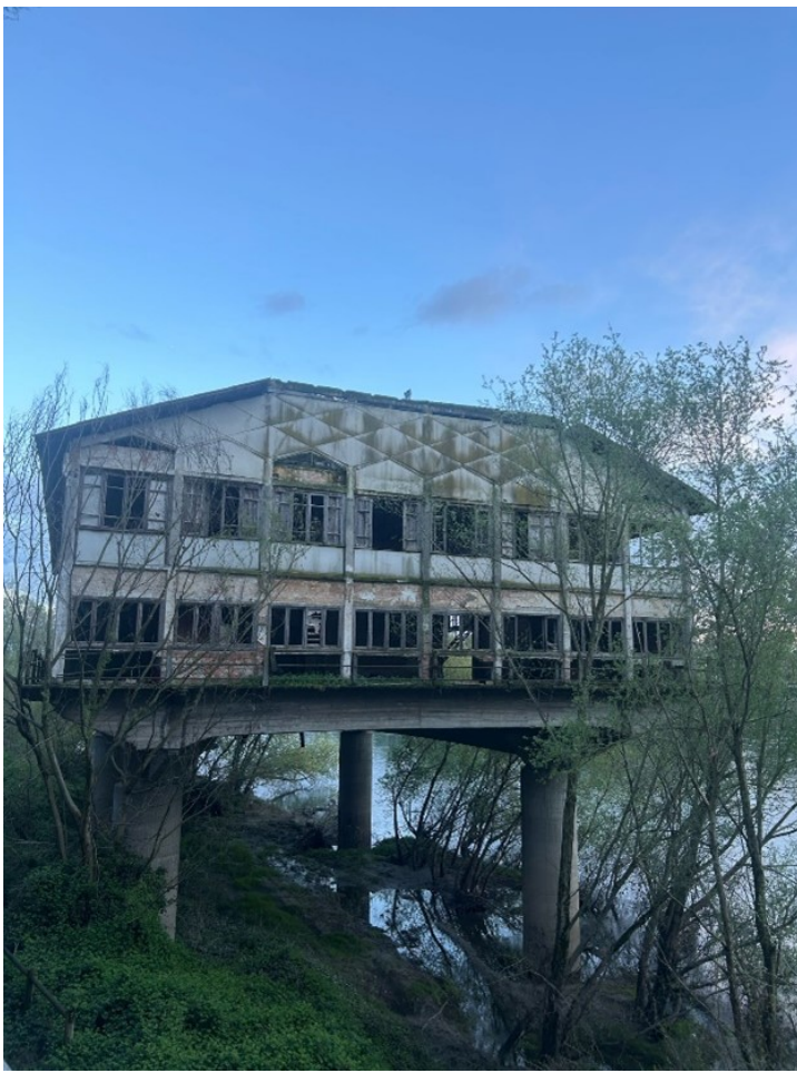
45. 17799°N, 9.16434°E Idroscalo, Pavia
